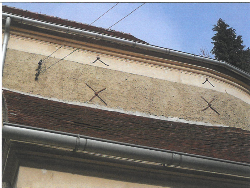
06. Ściana na kuchtą , dachówka nie równo ułożona
