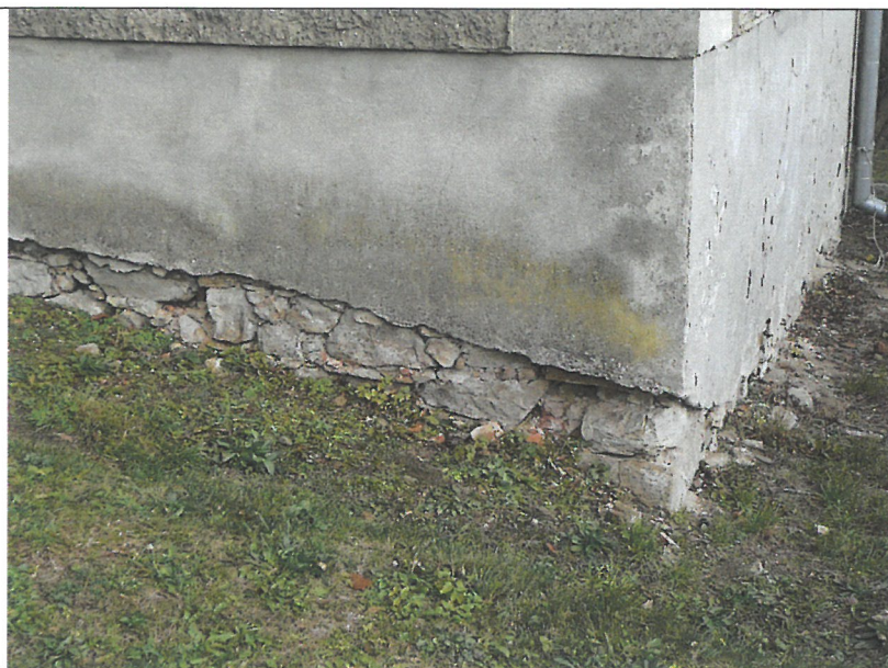
05. Przyziemie kruchty, ubytki muru i spoin (kamień część cegła) wilgoć od terenu
