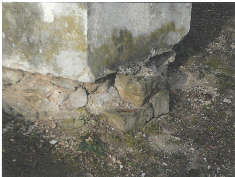
11. Przypora prezbiterium wilgotny kamień , cegły i zaprawa w przyziemiu.
