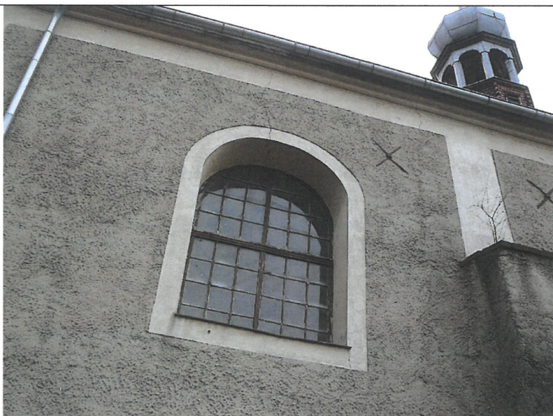
16. Ściana północna, rysa przez okno na całej wysokości, rynna przy gzymsie), na przyporze roślinność krzew.
