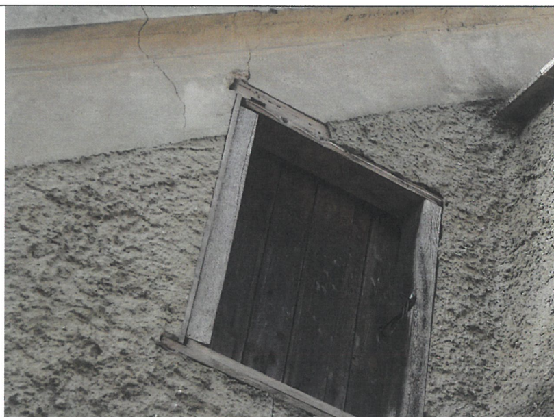
09. Ściana wschodnia kruchty, rysy nad oknem
