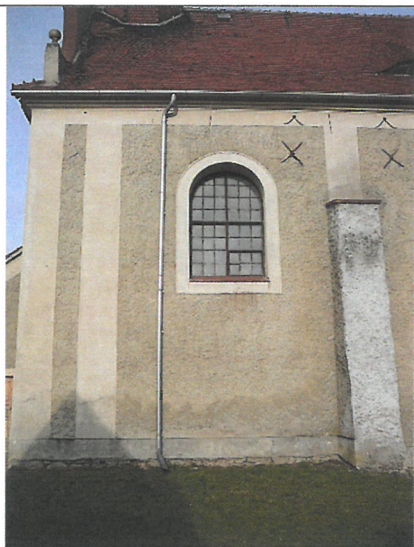
01. Południowe – widoczne kotwy, zawilgocone od terenu zawilgocone nad i pod rysą w nadprożu okiennym, przyporą idąca do góry, rynna na grunt widocznej muru z kamienia na wysokość terenu
