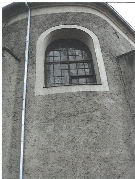
13. Prezbiterium (strona północno – zachodnia), rysa przez okno (na całej wysokości oraz odspojenia przypory od ściany (przypora od północy)
