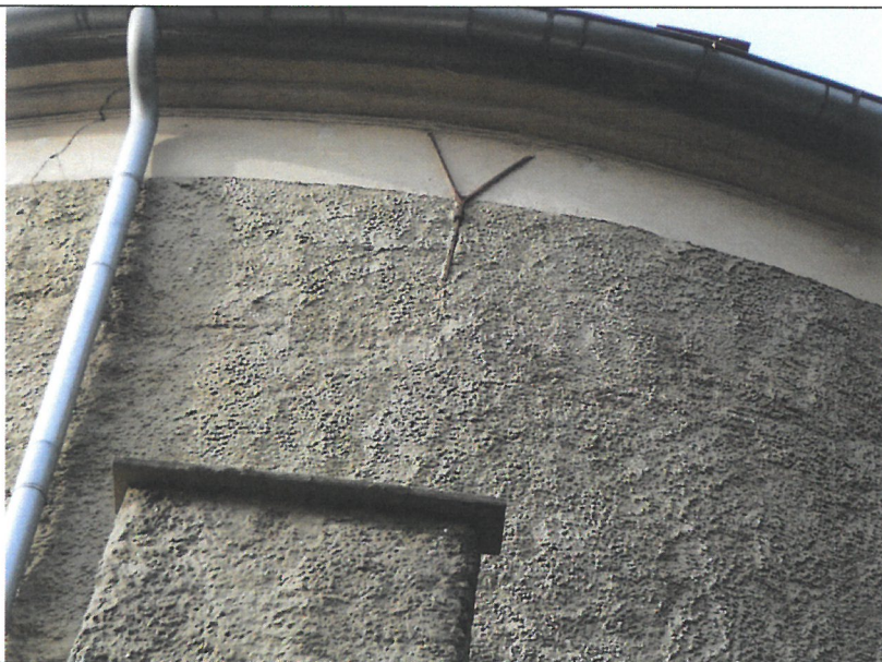
12. Prezbiterium, rysa w górnej części ściany (gzyms)
