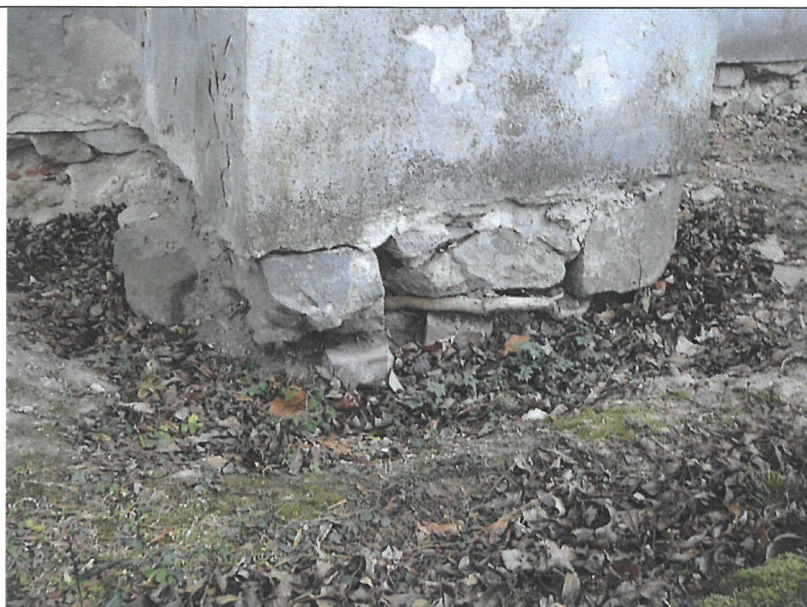
15. Przypora - rysa na całej wysokości oraz odspojenia przypory od ściany, przyziemie ubytki kamienia, spoin, przeróżnik kamieni
