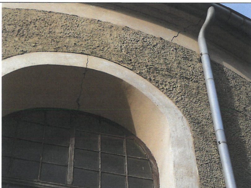
10. Ściana półkolista od zachodu (prezbiterium), rysy okna i gzymsu
