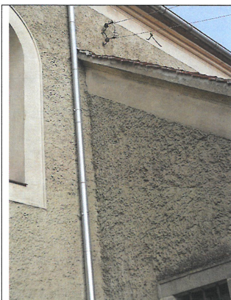
04. Kruchta od południa (zakrystia), ściana nie przewiązana z nową bryłą kościoła
