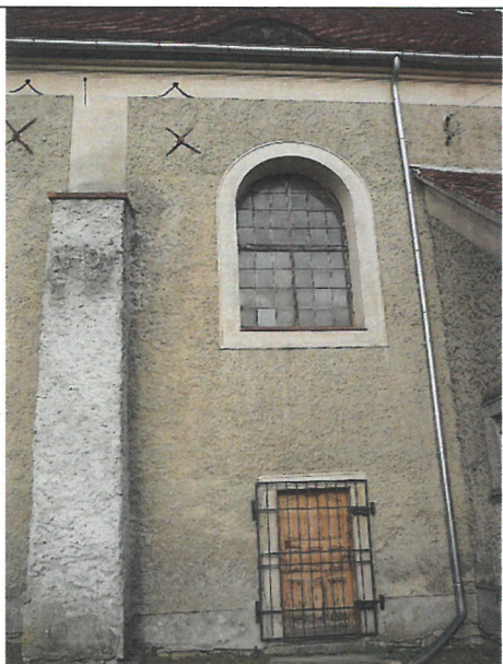
02. Rysa gzymsu, w oknie brak rysy, przyporą idąca do góry, rynna na grunt widocznej muru z kamienia na wysokość terenu, rura na teren
