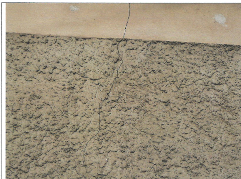
08. Rysa gzymsu na ścianie południowej
