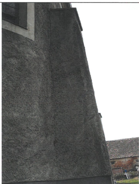
14. Przypora - rysa na całej wysokości oraz odspojenia przypory od ściany, odspojenie przypory na całej wysokości
